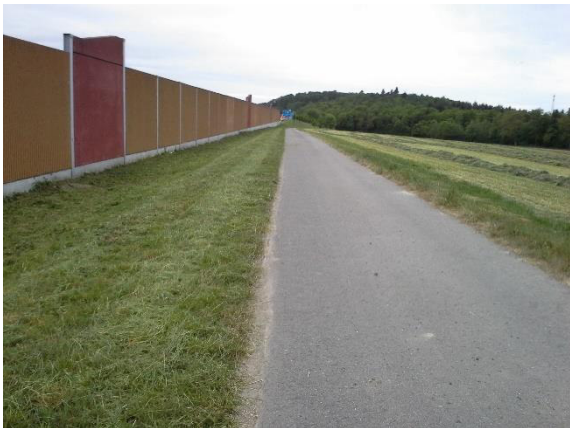
Abbildung 6: Asphaltweg und Lärmschutzwand an der Autobahn, südlich des Geltungsbereichs (Foto © DNP)
